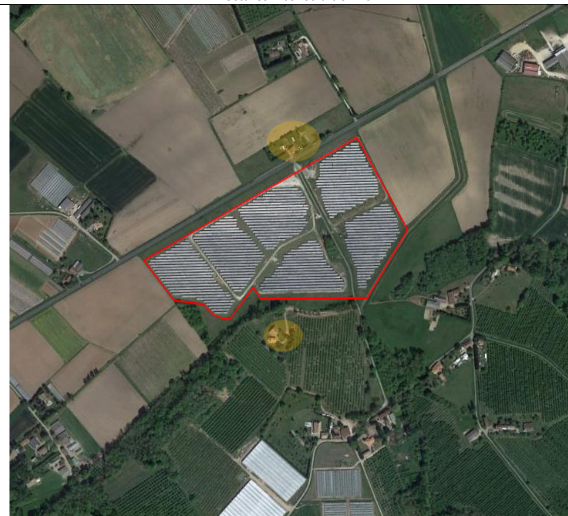
Parc solaire de Laffite-sur-Lot (47) - Luxel 12 hectares – construit en 2014
