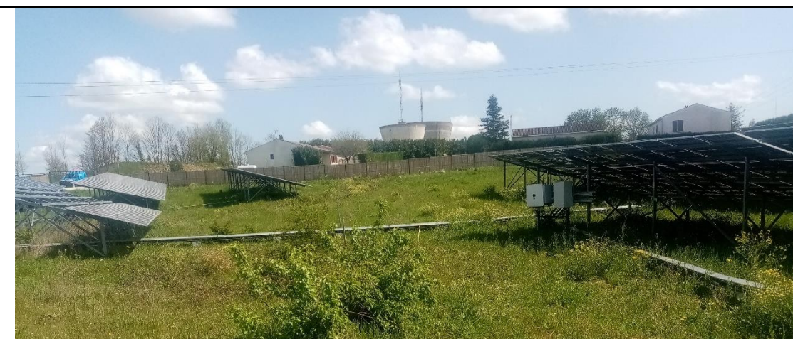
Source : Luxel, 2022 – vue depuis l'intérieur du parc
