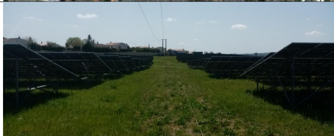
Source : Luxel, 2022 – vue depuis l'intérieur du parc
