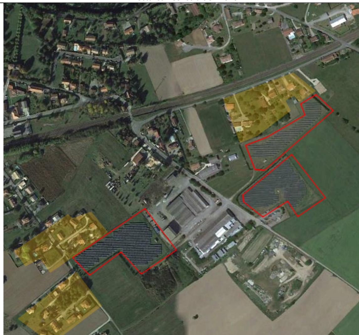
Parc solaire de Saint-Martory (31) - Luxel 4 hectares - Construit en 2010
